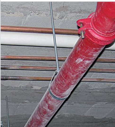
Rørbøjle, todelt FRSM, massiv
