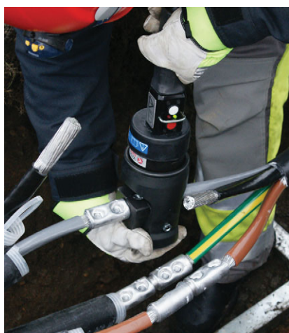
Dornpresning af Elpress pressemuffe ved hjælp af pressehoved V250
